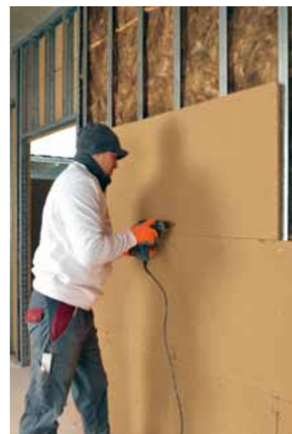
Die Trennwand wird mit halbem Plattenversatz geschlossen
