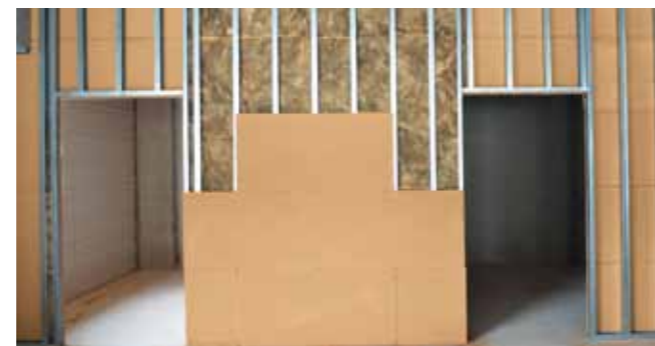
Gesamtansicht Trockenbauwand, teilweise mit Dämm-einlage und vorderseitiger Lehmplattenverkleidung
