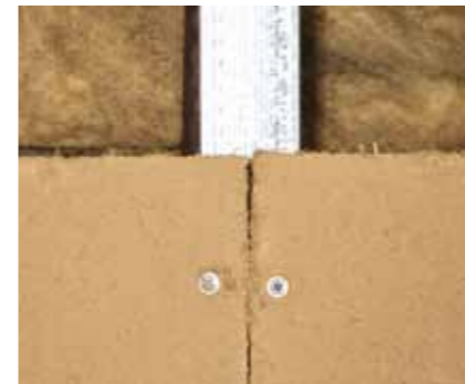
Plattenstoß, mit Schrauben befestigt
