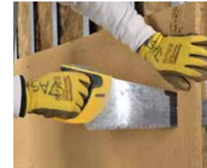
Bei Wandecken lassen sich die Platten mit dem Fuchsschwanz schneiden
