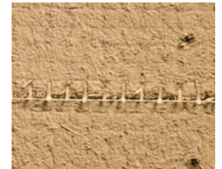
Am Plattenstoß sieht man das Glasfasergewebe und die Stroh-einlage. Hier halten phosphatierte Schnellbauschrauben die Platten.
