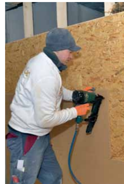
Auf vollflächiger Unterkonstruktion (z.B. OSB-Platten) wird mit Breitrückklammern und Schussapparat befestigt
