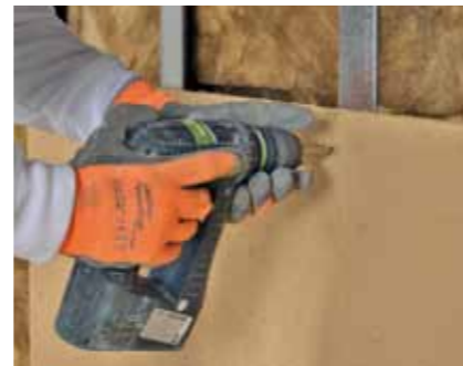
Befestigung mit Schnellbauschrauben auf Metallunterkonstruktion
