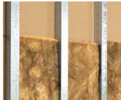
Ständerwand Rückseite mit Lehmbauplatten und eingelegter Mineralwolle
