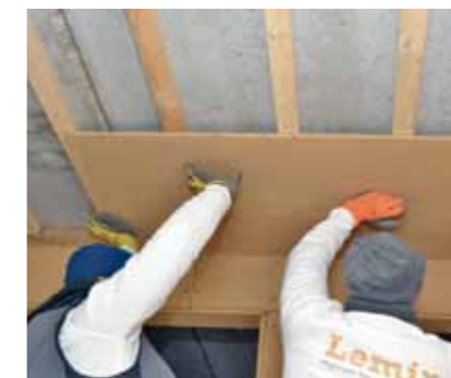
Lehmplattenmontage an der Decke, Achsenabstand der Unterkonstruktion = 31,25 cm
